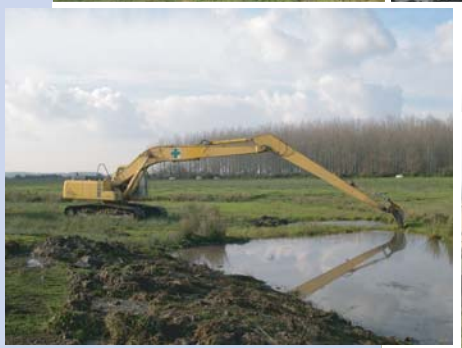
Terrassement et reprofilage
