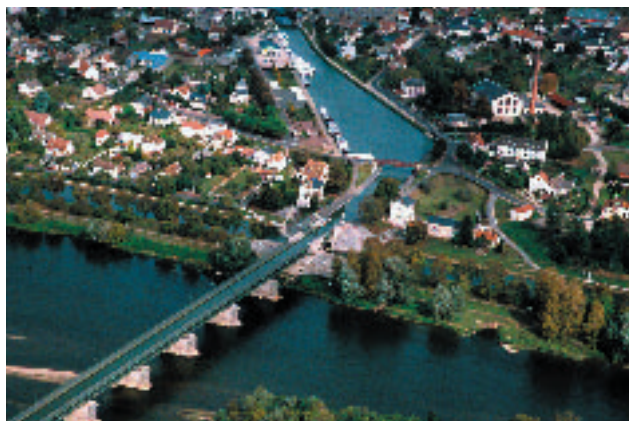
Le pont-canal à Briare (Loiret).
