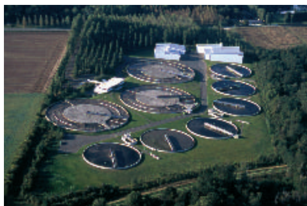
Station d'épuration à Chaingy (Loiret).
