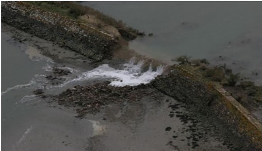
*Illustration 7: rupture d'une digue dans les marais salants de Guérande - source DREAL*
