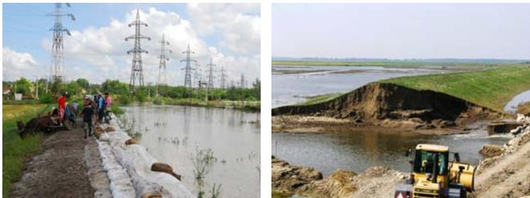
Figure 3. A gauche : Consolidation d'une digue avec des sacs de sable à □endreni en 2010. A droite : Construction d'une digue provisoire sur la rivière Geru dans la zone de Lungoci, travaux exécutés par Apele Romane en 2010 (clichés : Administrația Națională « Apele Române »)
