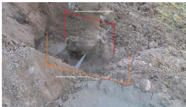
Fig. 9 Wykonanie kolumny TOP-Jet. Na fotografii zaznaczono zasięg mieszania mechanicznego grantu oraz znacznie większy zasięg mieszania strumieniem spoiwa.
