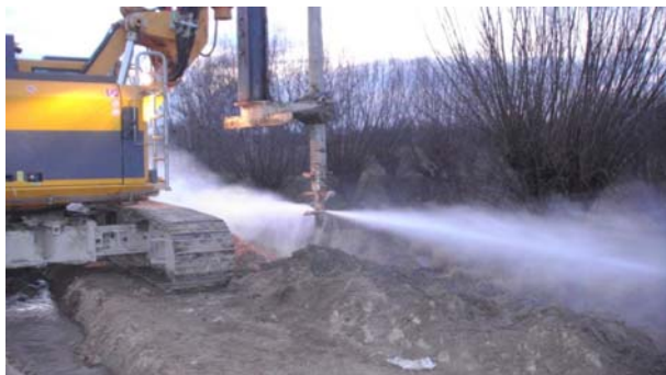
Fig. 8 TOP-Jet. Połączenie klasycznego wglębnego mieszania (widoczne mieszadło) z urabianiem gruntu strumieniem spoiwa.
