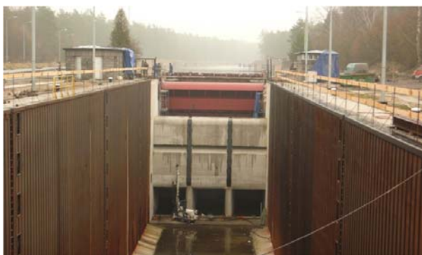
Fig. 1 Przykład uszczelnienia i wypełnienia pustek sufozyjnych. Prace iniekcyjne prowadzone w warunkach bardzo wysokiego ciśnienia wód porowych. Kanał Gliwicki.
