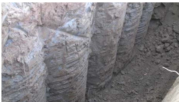
Fig. 10 Odsłonięcie przesłony w formie palisady kolumn TOP-Jet. Widoczne charakterystyczne bruzdy na pobocznicach jako efekt urabiania gruntu strumieniem.
