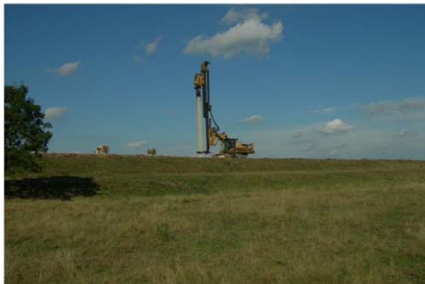
Fig. 7 Wykonanie przesłony w technologii WIPS poprzez kolejne wwibrowanie kształtownika połączone z iniekcją spoiwa od dołu ku górze.
