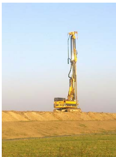
Fig. 5 Wykonanie palisady DSM. Prawy wał Wisły w rejonie Niepołomic. Urządzenie Bauer RG16.
