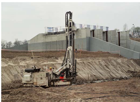
Fig. 3 Wykonanie pionowej przesłony jako uszczelnienie gruntu pod korpusem zapory zbiornika Kuźnica Wąreżyńska. Iniekcja wykonana spoiwem na bazie modyfikowanych ilów.
