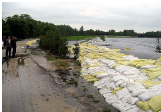
Rys. 12. Miejsce budowy wału z worków na drodze powiatowej 2466P. Źródło: Łukasz Sobolewski
