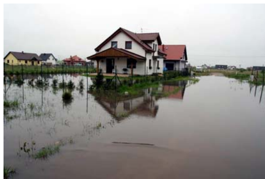
Rys. 4. Rokietnica - Osiedle Spokojne. Przykład osiedla zalanego wodą z opadów atmosferycznych wskutek lokalizacji w terenie bezodpływowym i nieprzepuszczalnym.
