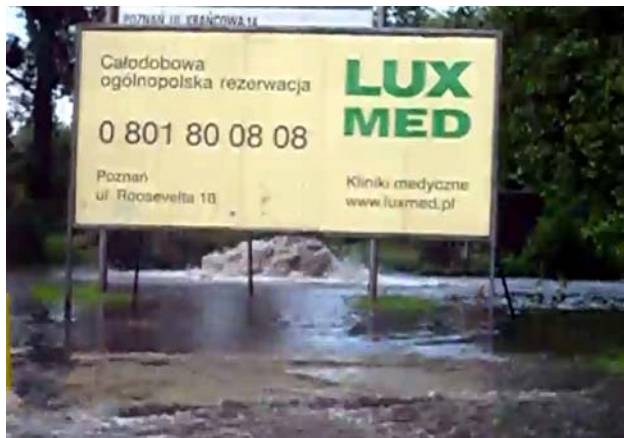
Rys. 8. Woda wybijająca się po opadzie przez studzienki położone na kolektorze prowadzącym strumień Wierzbak. Źródło: archiwum autora
