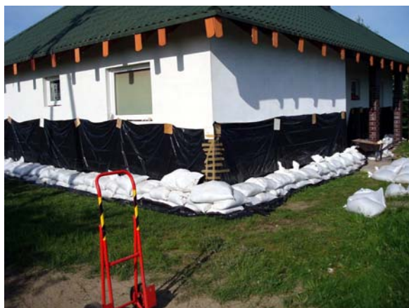
Rys. 6. Osiedle Wiórek - budynek mieszkalny przygotowany do indywidualnej ochrony.
